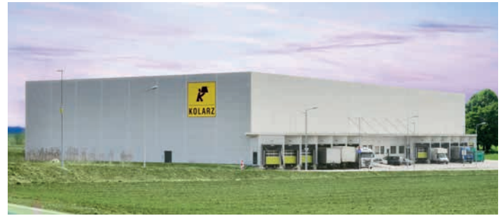
Logistikzentrum Müllendorf, Österreich | Logistics Center Müllendorf, Austria
